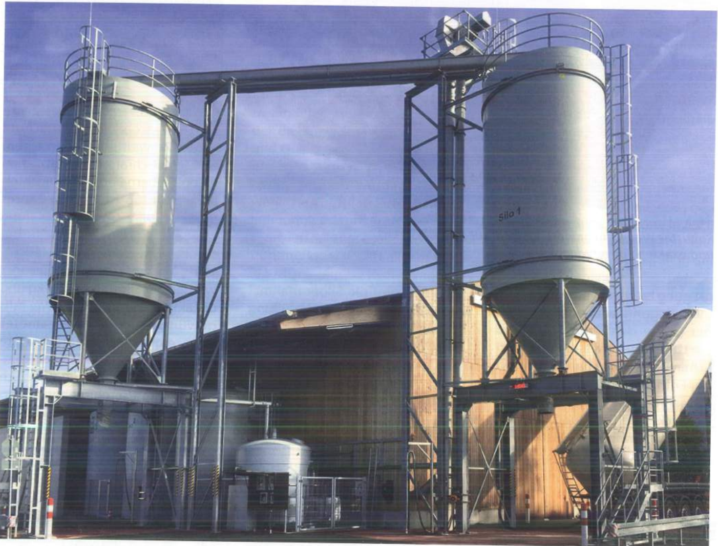
Neues Salzsilos der Stadtreinigung Leipzig mit robusten Wägezellenmodulen vom Typ VC 3500
